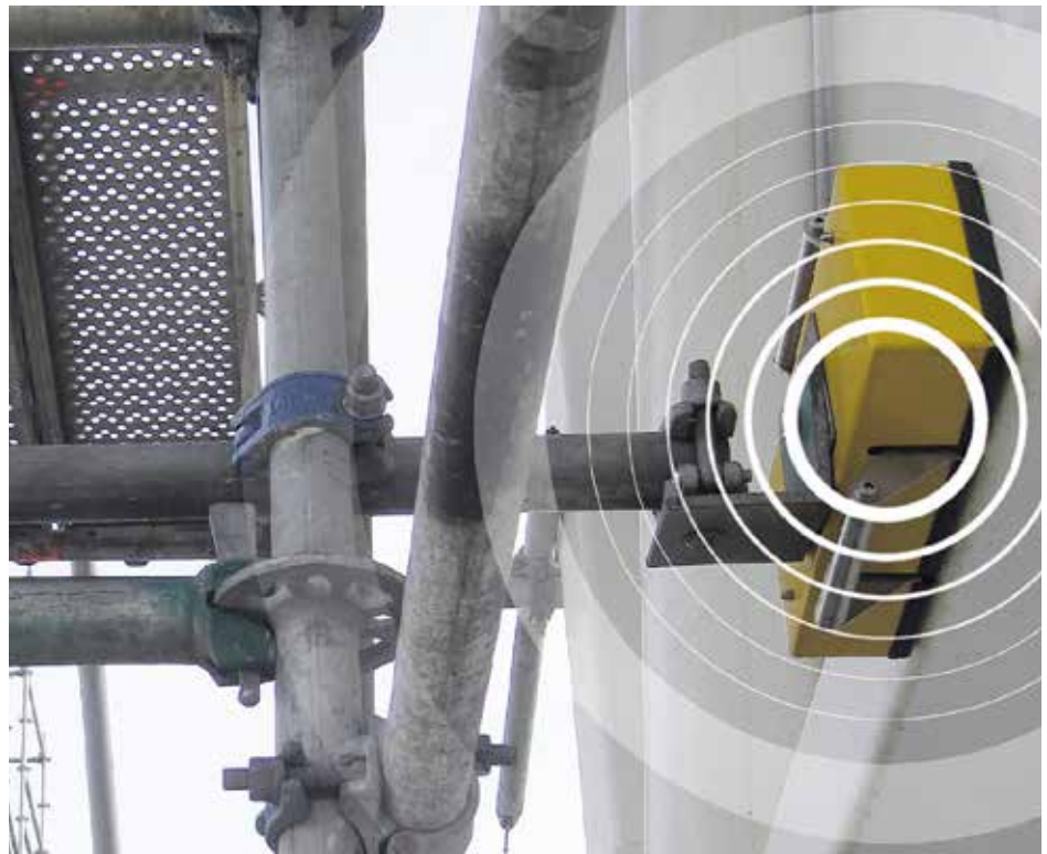
Bilfinger Industrial Services werkt als eerste bedrijf in de Nederlandse steigerbouw met magnetische ankers.
